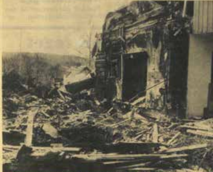
• Så här såg Bollsta Folkets hus ut efter den stora branden i april. Nu ligger återuppbyggnaden högst på kommunens prioriteringslista.
