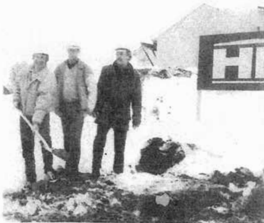
□ Ordförande i Bollsta folketshusförening Lars-Åke Frykholm, tar del av spadtaget till nytt hus under överseende av Sven-Erik Nyman, bygg Hallström & Nisses (mitten) och Thor Dahl, arkitekt från K-Konsult (t)
