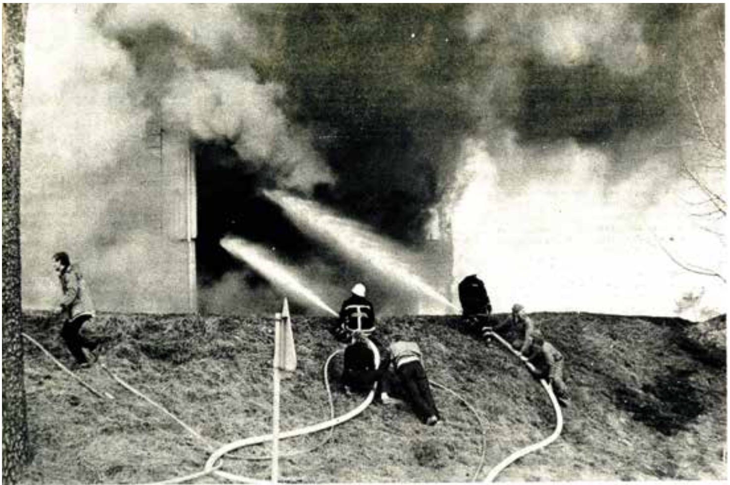
Den starka nordvästliga vinden gav elden en oerhörd kraft och försvarade släckningsarbetet för brandkårerna från Kramfors, Nyland, Sollefteå och Kramfors flygplats.
