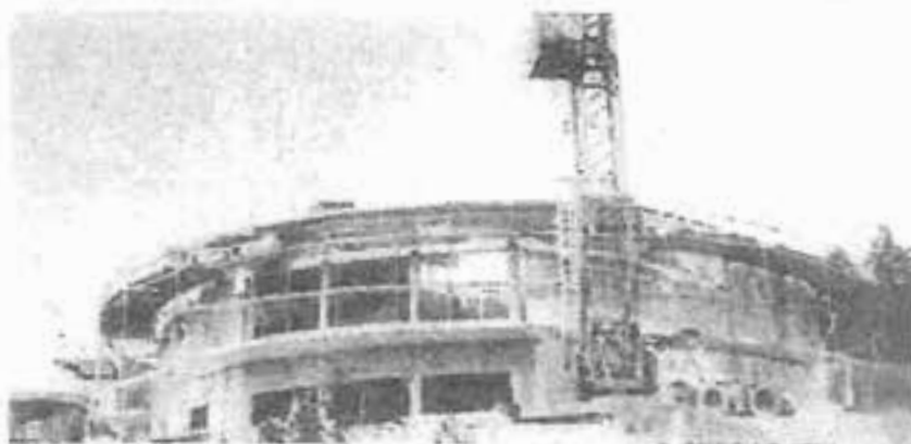
□ Bollsta Folkets Hus strax innan lanterninen lyfts på.
