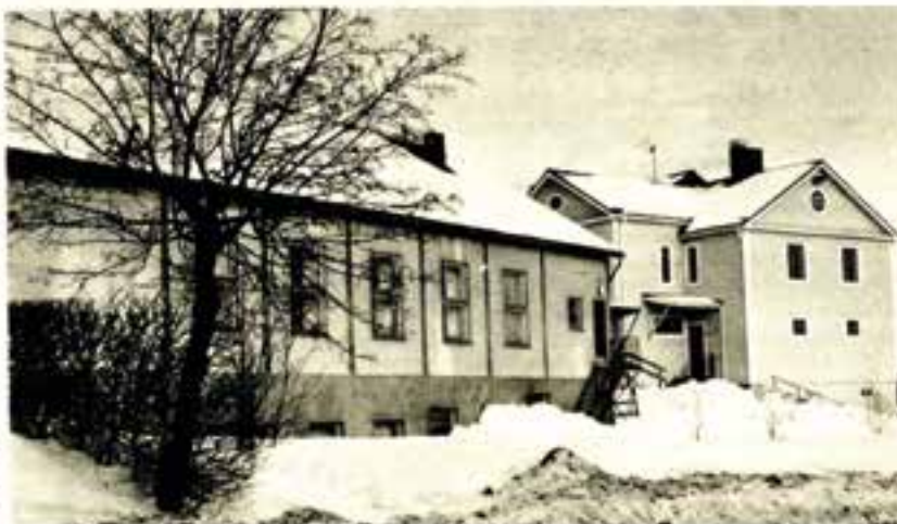
Bollsta Folkets Hus har fräschats upp även utvändigt i samband med ombyggnaden.
